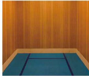
エレベーター養生
