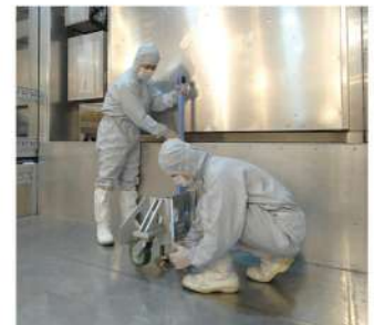
クリーンルーム内搬入設置作業
